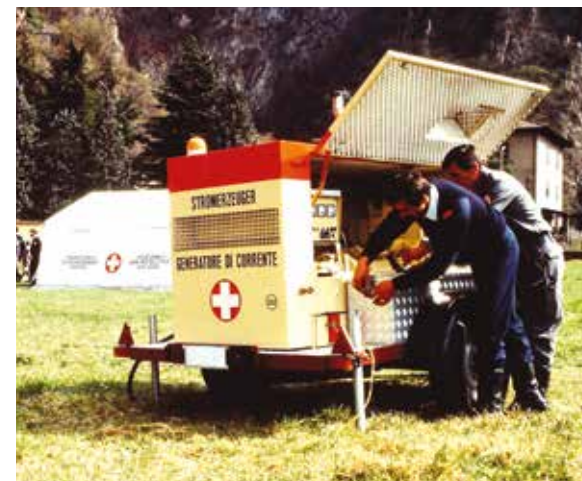
Generatore elettrico 40 anni fa.
